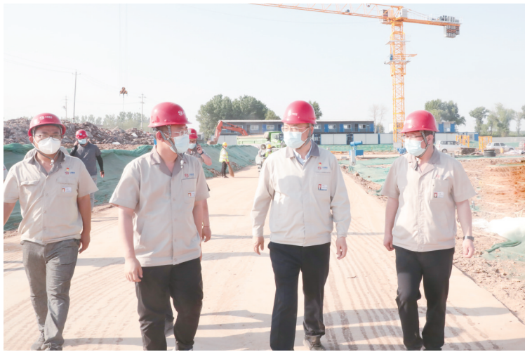
图为韩珍堂在新园区配套住宅项目现场调研
